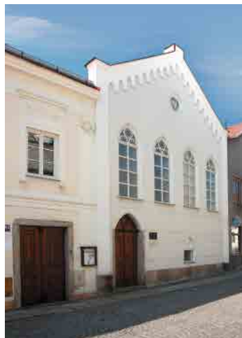
Bývalá synagoga v Kostelní ulici
